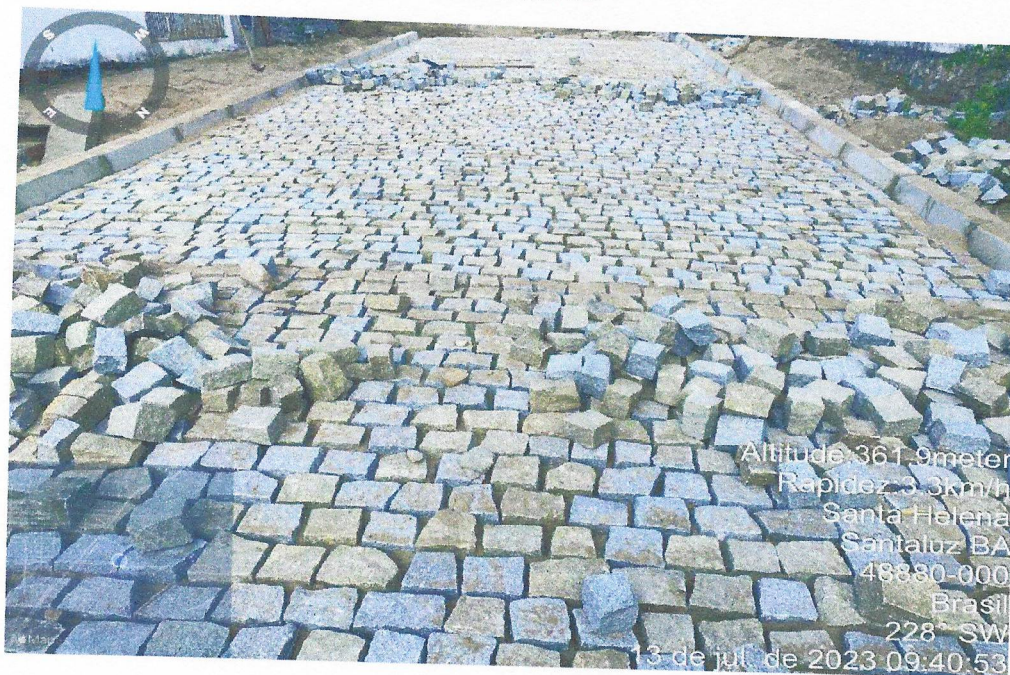
Execução de Pavimentação da Rua projetada 04 Trecho I
