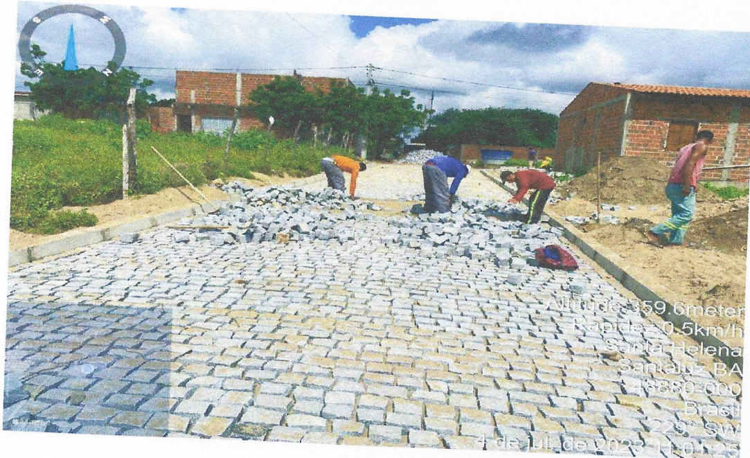
Execução de Pavimentação da Rua projetada 04 Trecho II
