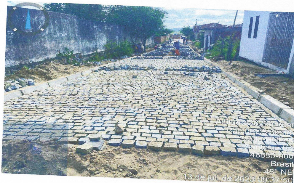
Execução de Pavimentação da Rua projetada 04 Trecho I
