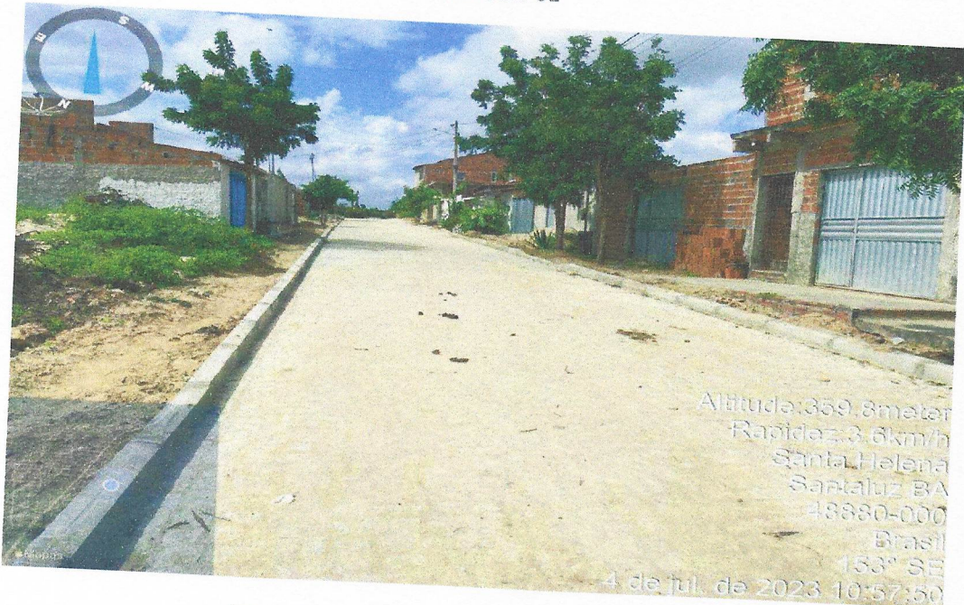
Execução de Pavimentação da Rua projetada 08
