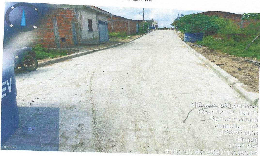
Execução de Pavimentação da Rua Projetada 07
